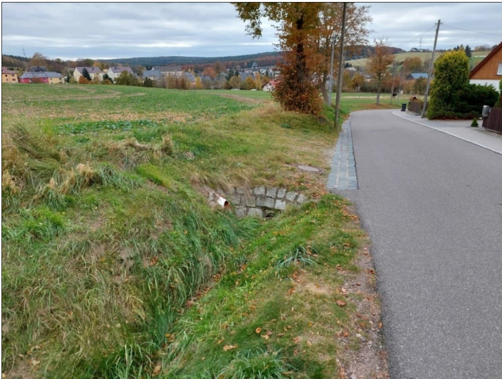
Ende des Entwässerungsgrabens und Beginn der Verrohrung in Höhe Flurstück 196/f
