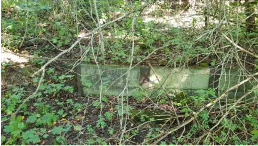
Fundamentreste von Gebäuden auf der südlichen Hälfte des Flurstücks
