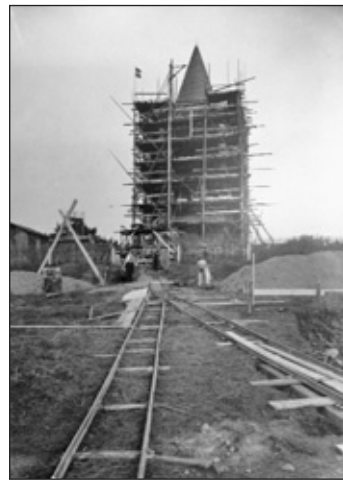
Foto vom Bau des Wasserturmes, © Deutsches Stuhlbaumuseum
