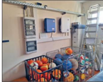
Um den Stromverbrauch zu senken und die CO<sub>2</sub>-Emissionen zu vermeiden, wurden seit Ende 2024 die Hallenbeleuchtung auf LED umgerüstet und eine Photovoltaikanlage mit entsprechendem Stromspeicher errichtet. Die Maßnahme wurde zum 31.03.2025 abgeschlossen.
