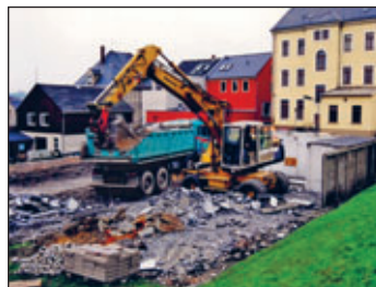
Bauarbeiten Parkplatz Rathaushof
