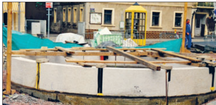
Errichtung des Brunnenbauwerks
