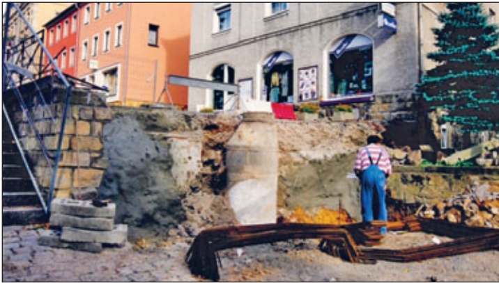
Sanieren der baufälligen Mauer
